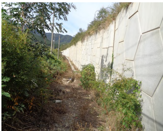
7공구 패널식 옹벽 11
