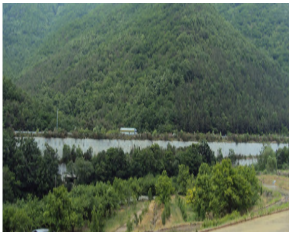
3공구 패널식 옹벽 01
