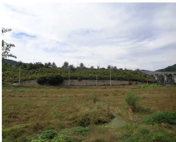
5공구 블럭식 옹벽 06
