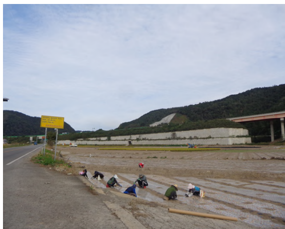
7공구 패널식 옹벽 12
