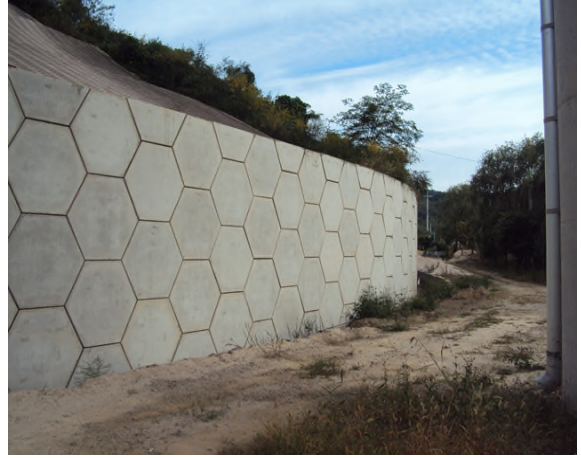
8공구 패널식 옹벽 14
