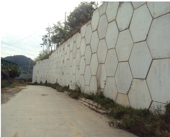
9공구 패널식 옹벽 15
