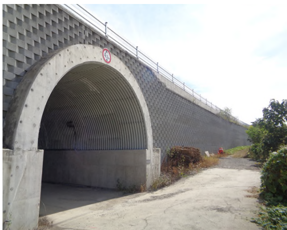
6공구 블럭식 옹벽9
