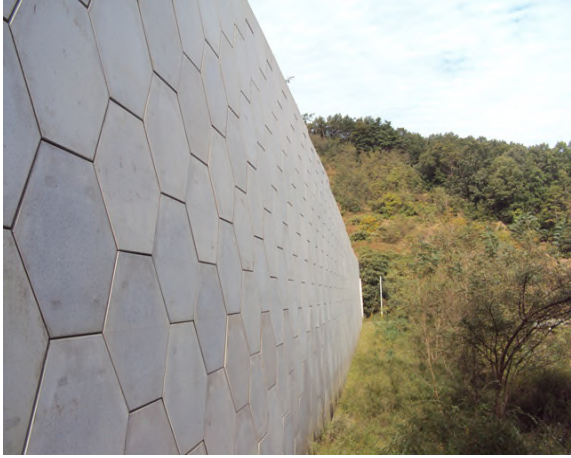
8공구 패널식 옹벽 13
