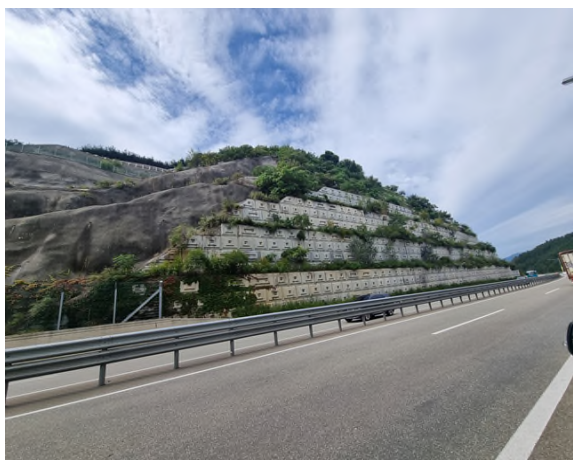
4공구 패널식 옹벽 05
