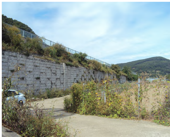
6공구 패널식 옹벽 08
