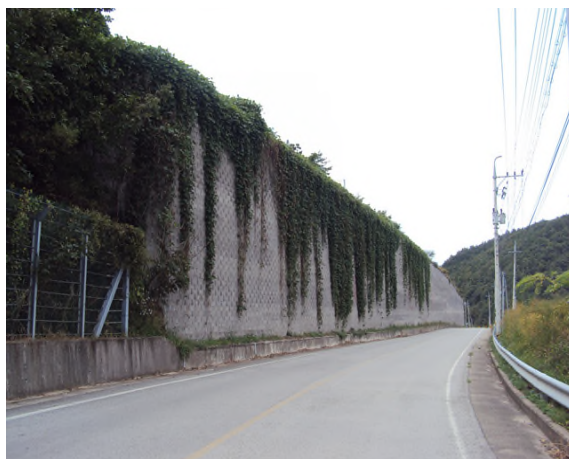
4공구 블럭식 옹벽 04
