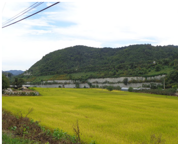
3공구 패널식 옹벽 02
