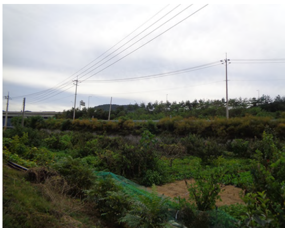
3공구 블럭식 옹벽 03
